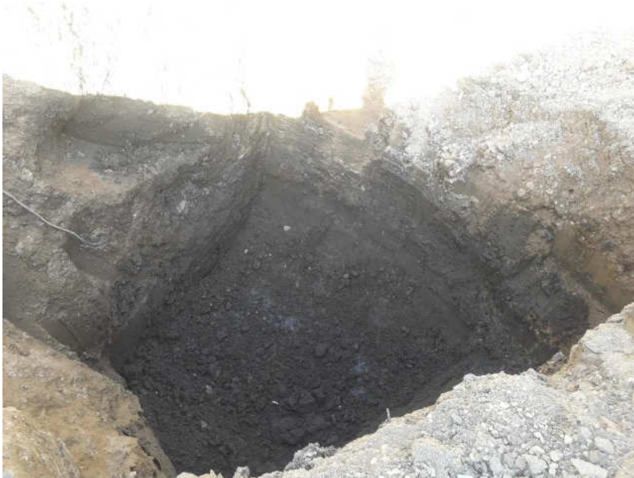
Foto 3: scavo zana plinto
