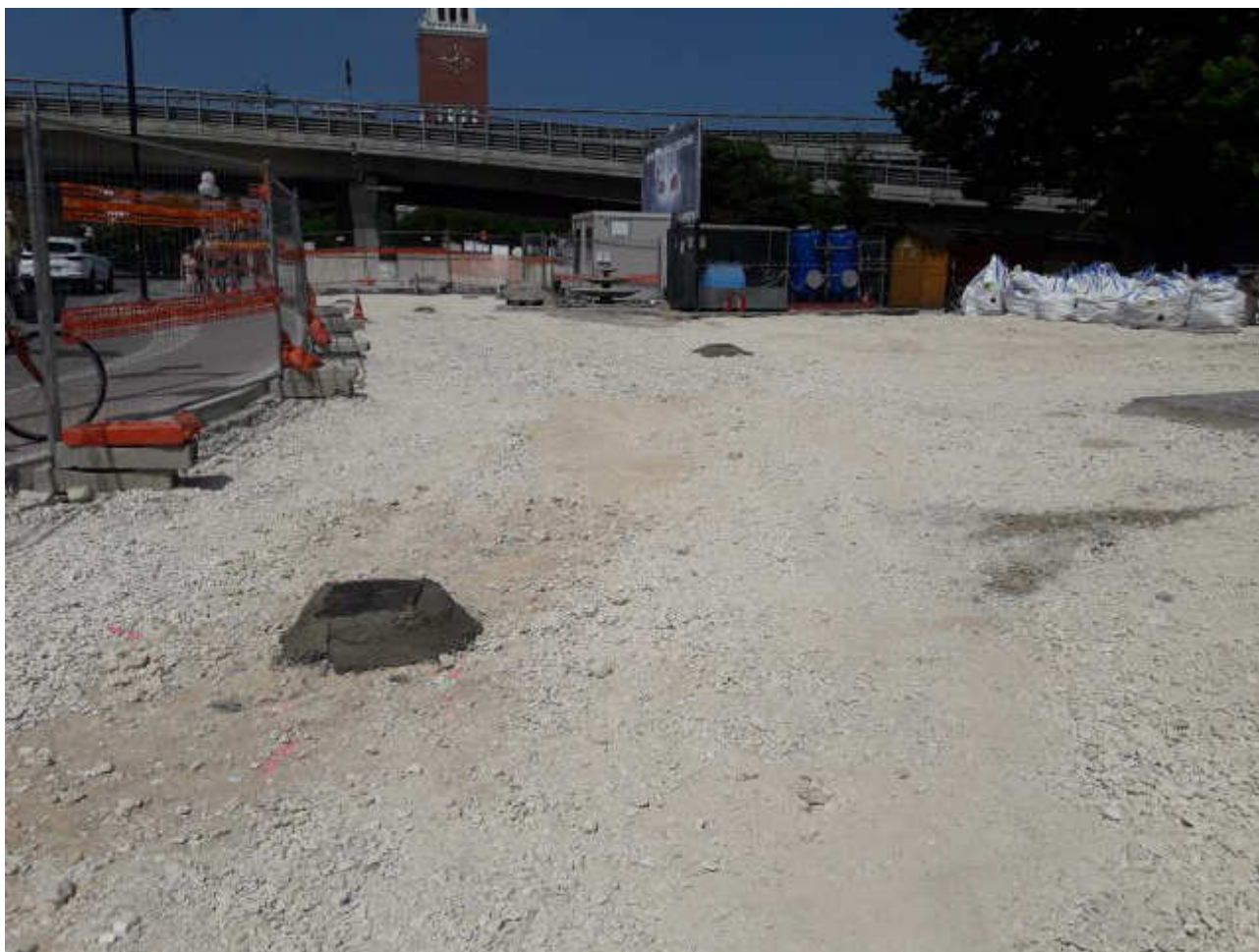
Foto 8: fase di ripristino dell'area 1
