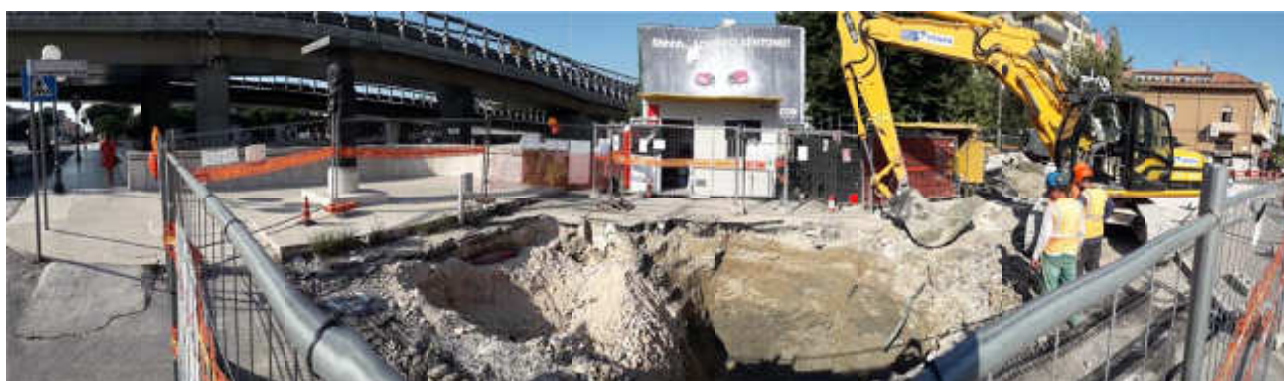
Fig.17 Panoramica dello stesso saggio visto da sud, è ben visibile il livello di limo grigio che si rinviene a 2 metri sotto il piano di asfalto
