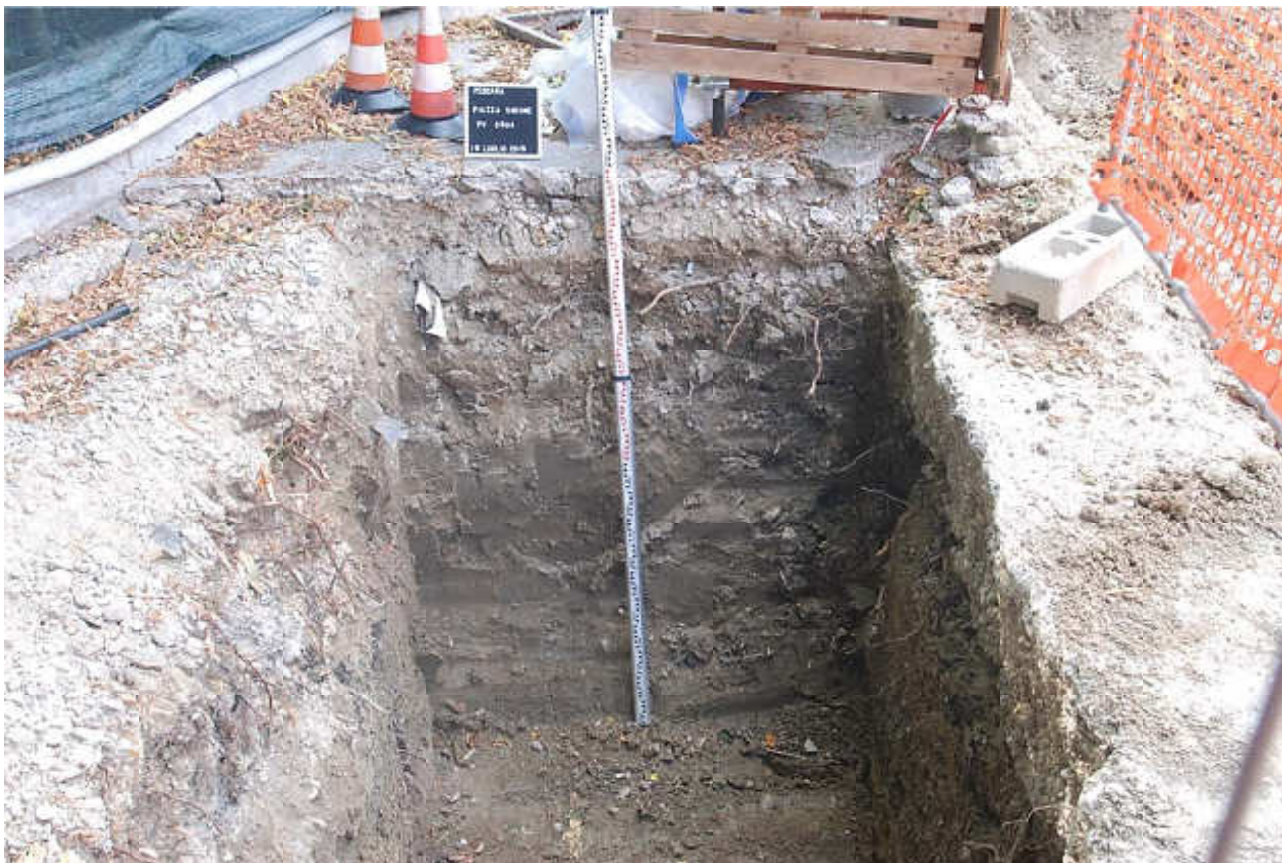
Fig.5 Il primo serbatoio rimosso
