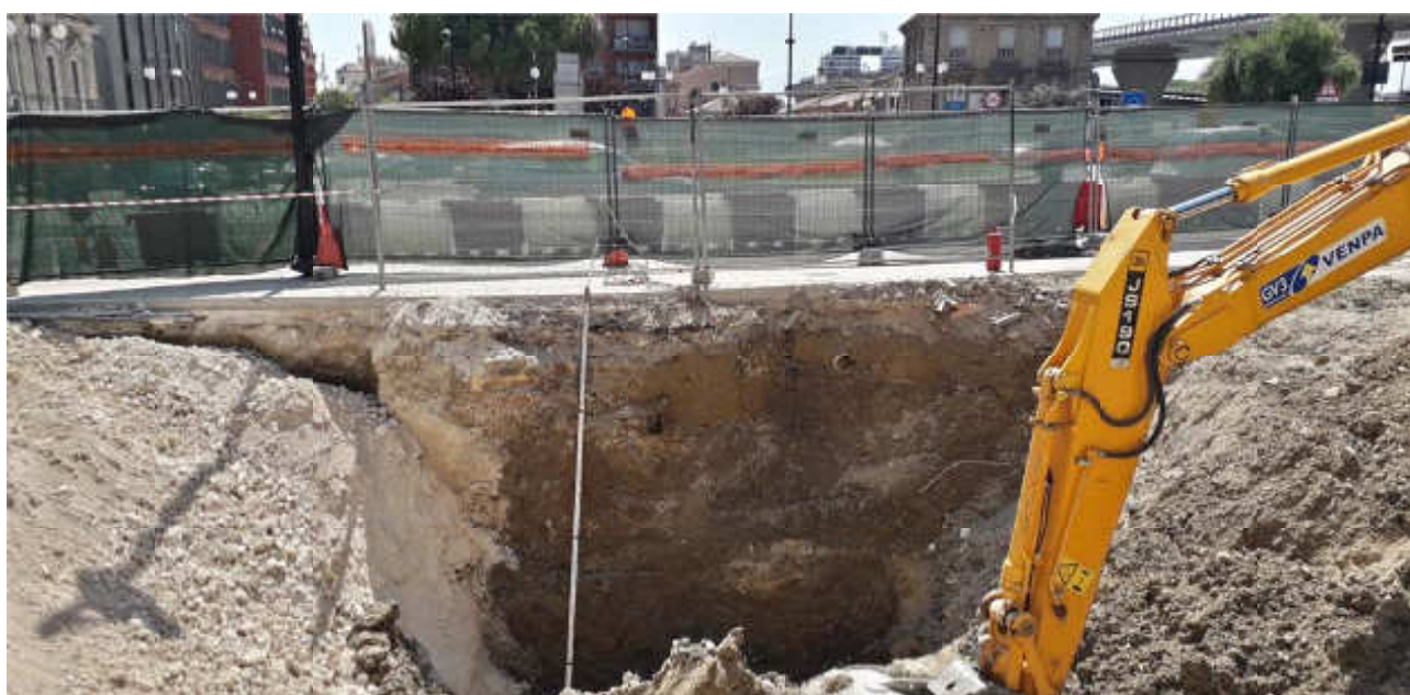
Fig. 10 La sezione vista da nord. Lo strato di riporto supera i 4 metri di spessore
