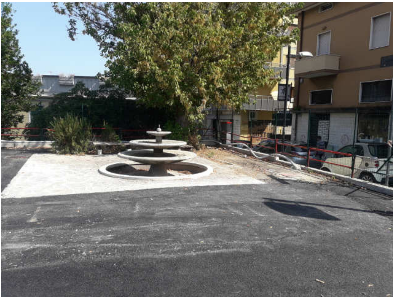
Foto 11: Ripristino finale dell'area 1
