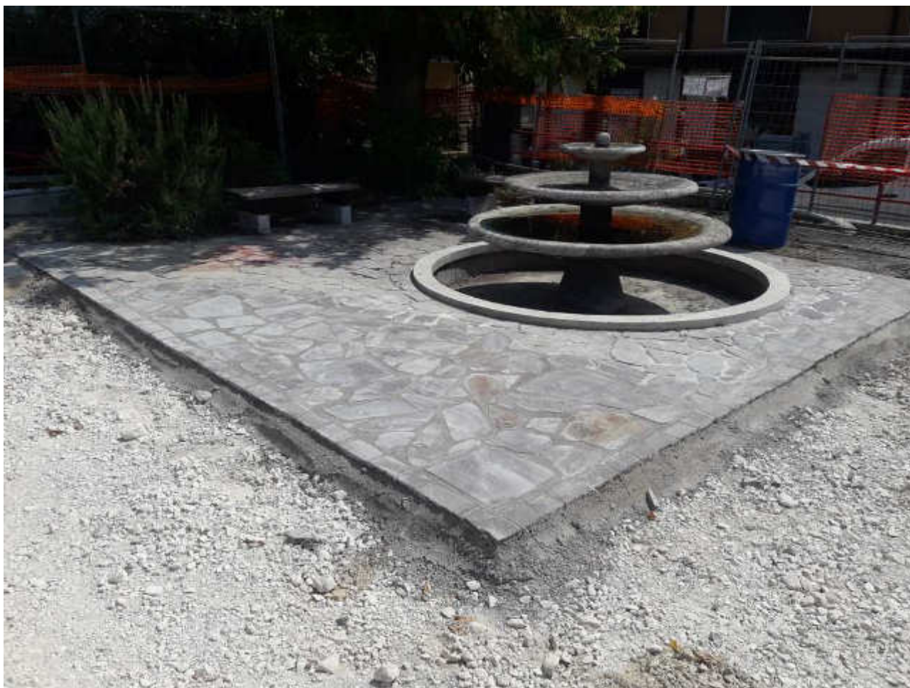
Foto 10: ripristino fontana lato porto
