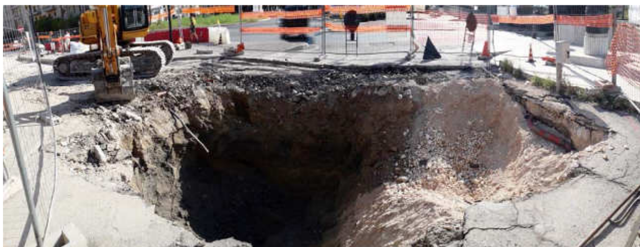
Fig. 16 La rimozione dell'ultimo serbatoio in corrispondenza del lato del ponte vista da nord
