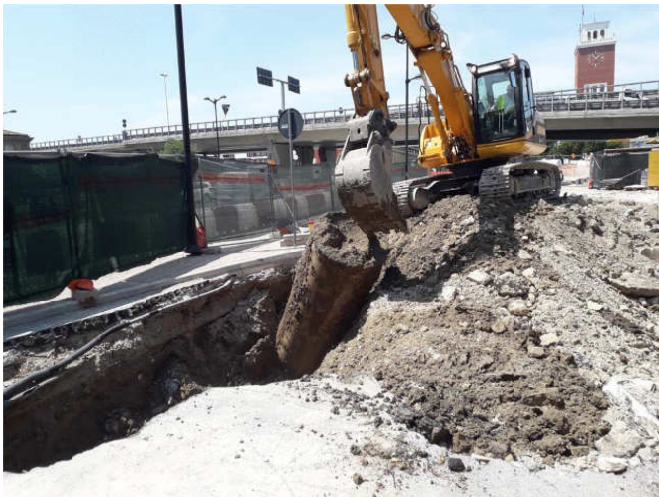
Fig.7 La rimozione del serbatoio a estremità convesse
