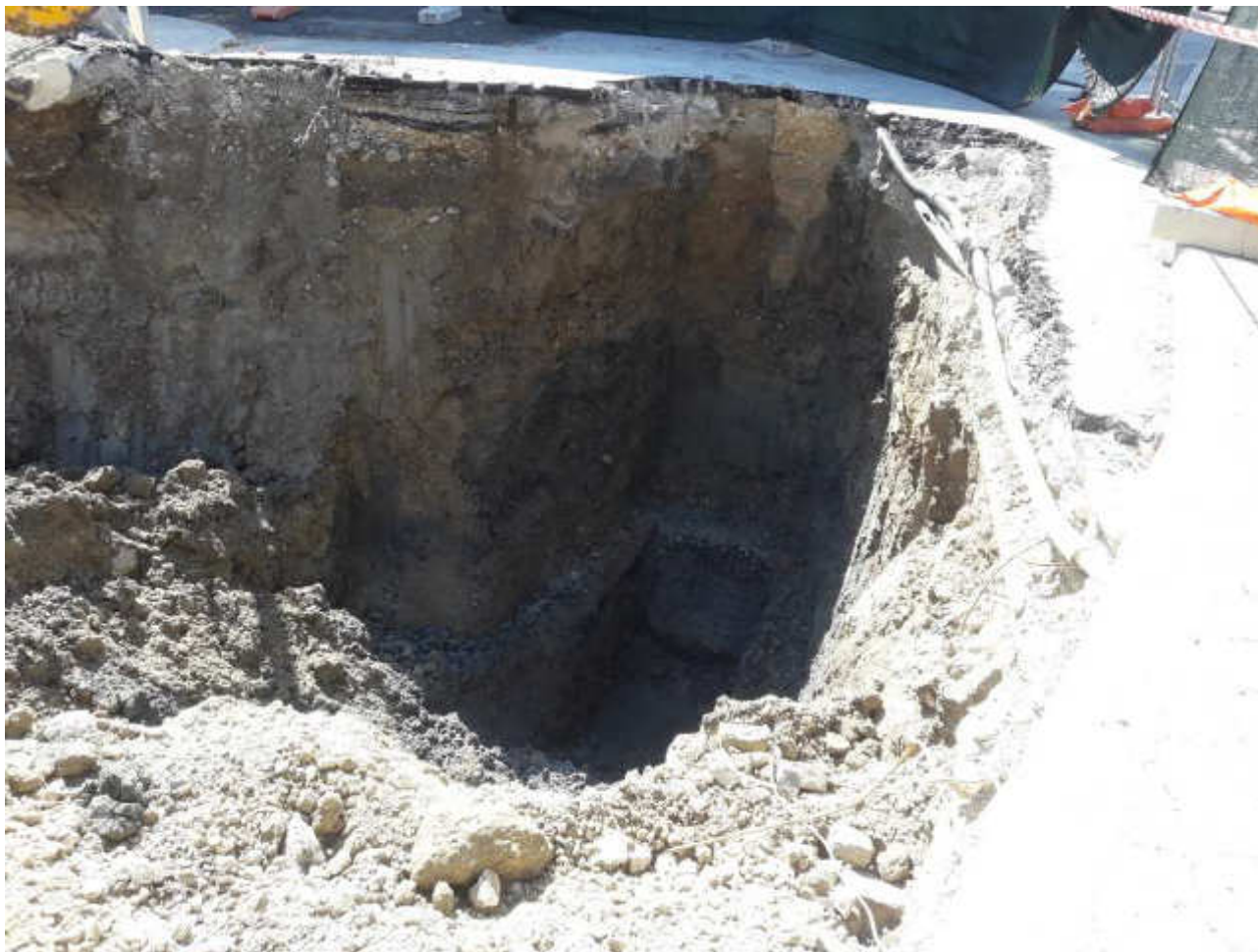
Foto 1: fase di scavo zona TK Ghost
