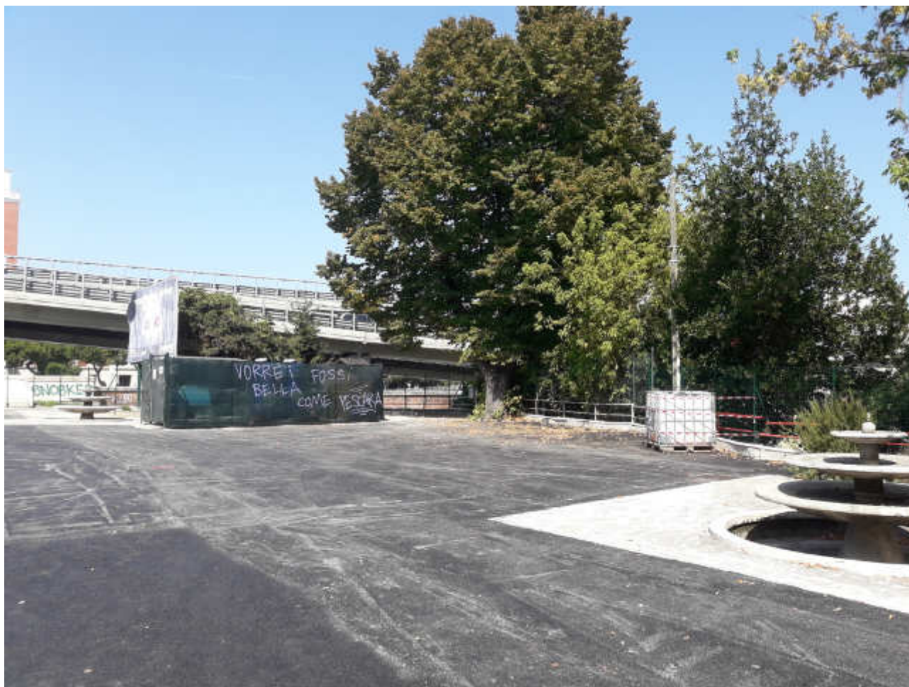
Foto 12: Ripristino finale dell'area 2
