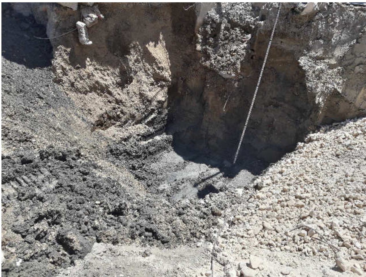
Foto 2: scavo zona parco serbatoi
