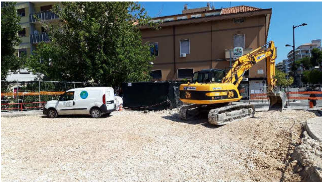
Foto 9: fase di ripristino 2
