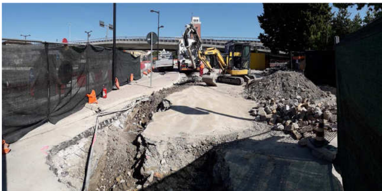
Fig.4 Escavatore a risucchio all'opera, in primo piano i due serbatoi rinvenuti nell'angolo sud.
